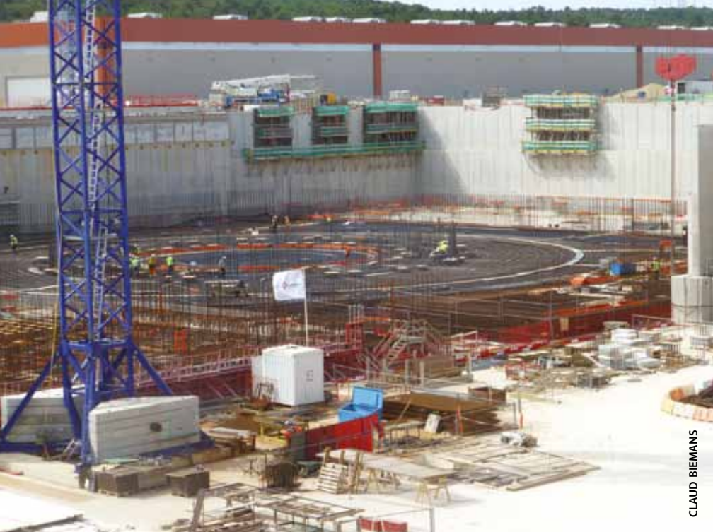
Werk aan de fundering van de tokamak en cryostaat in mei 2014.
